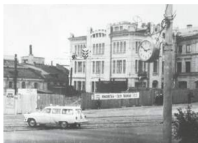
Начало строительства нового здания Дома моделей на ул. Маяковского. 1968 год
