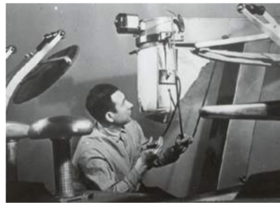
Горьковский механический завод. Брюнный манекен-автомат для чистки, отпарки и глажки. Мастер Н.В. Сарогин за регулировкой манекен-автомата. 1966 год
