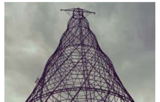
Шуховская башня на Оке – уникальная гиперболическая конструкция инженера Шухова, внесенная в список всемирного наследия. Ее высота 128 метров
