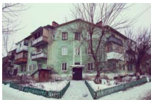
Первый жилой многоквартирный дом Дзержинска был построен в 1930 году и находится по адресу: проспект Дзержинского, 5
